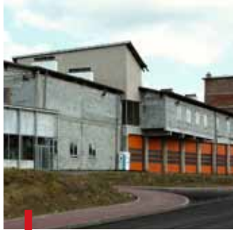
Ukończona w 60 procentach budowa obiektu będzie kontynuowana
