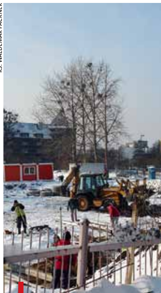
Mimo ostrej zimy prace przy budowie trwają. Stacja ma być gotowa za pół roku
