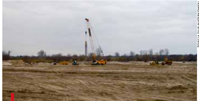
W najbliższym czasie przy Trześniówce nowe obwałowanie będzie gotowe
