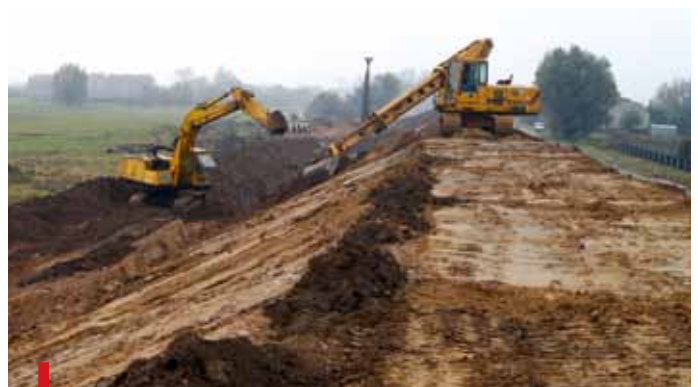
W Łukowcu (gm. Koprzywnica) prace remontowe nie ustają
