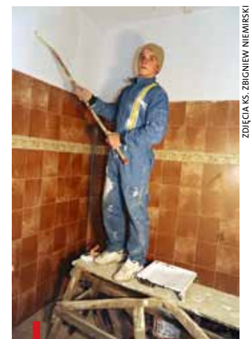
W prace wykończeniowe włączyli się uczniowie szkoły budowlanej w Ostrowcu Świętokrzyskim
