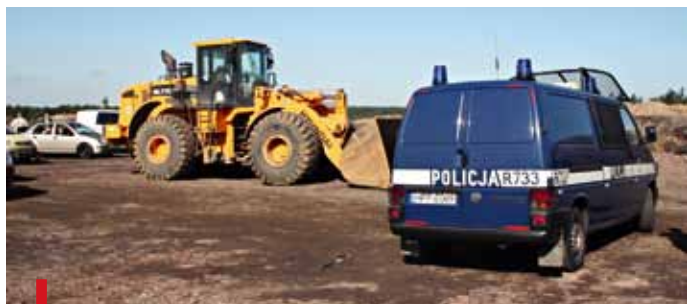
Policja wkroczyła na teren budowy autostrady A1
