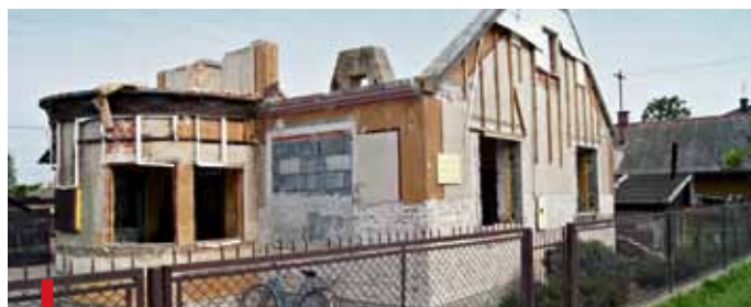
Wiele budynków mieszkalnych w skutek tegorocznej powodzi uległo całkowitemu zniszczeniu. Na zdjęciu: rozbiórka domów w Wielowsi
