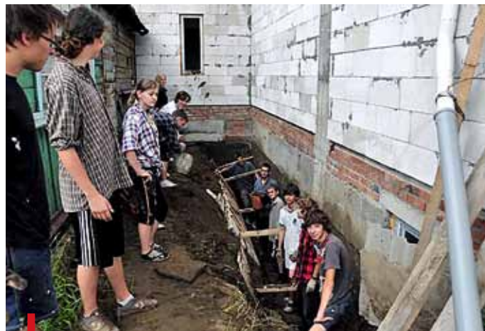
Jedna z cięższych prac – kopanie rowów przy kościele
