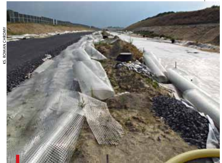
Od ponad siedmiu miesięcy na budowie autostrady A1 od Świerklan do granicy państwa z Republiką Czeską w Gorzyczkach nie ma ani jednego robotnika
