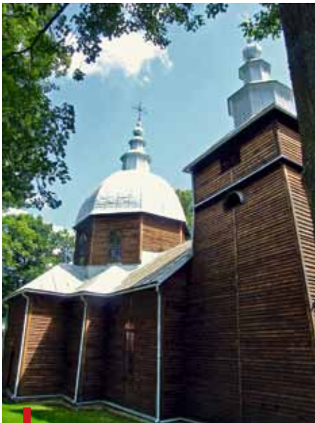
ŻŁOCKIE. Cerkiewną świątynię w XIX w. postawiono na rzucie krzyża, zastosowanym na tym terenie po raz pierwszy, i nakryto oryginalną ośmiopoliową kopułą na tamburze
