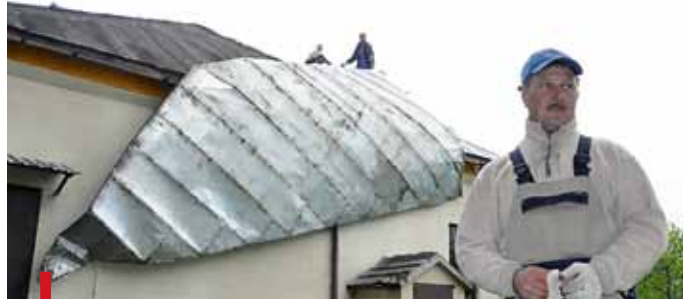
Ostatnie chwile starej blachy na dachu kościoła w Pyrzanach. – Pochodziła z 1946 roku – mówi szef firmy budowlanej Sylwester Oźga
