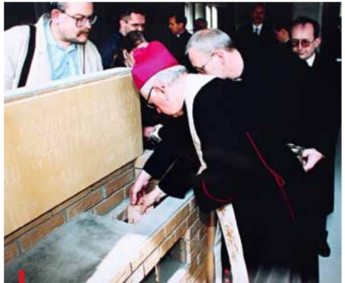
2003 r. Wmurowanie kamienia węgielnego pod budowę gmachu Wydziału Teologicznego Uniwersytetu Śląskiego
