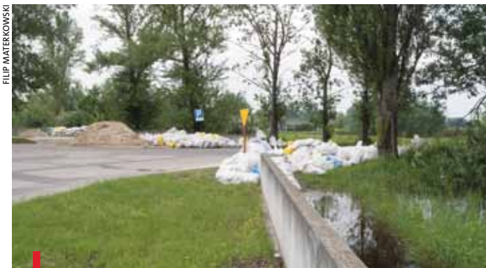
Po zewnętrznej stronie muru zabezpieczającego elektrownię jeszcze przez kilkanaście dni stała woda
