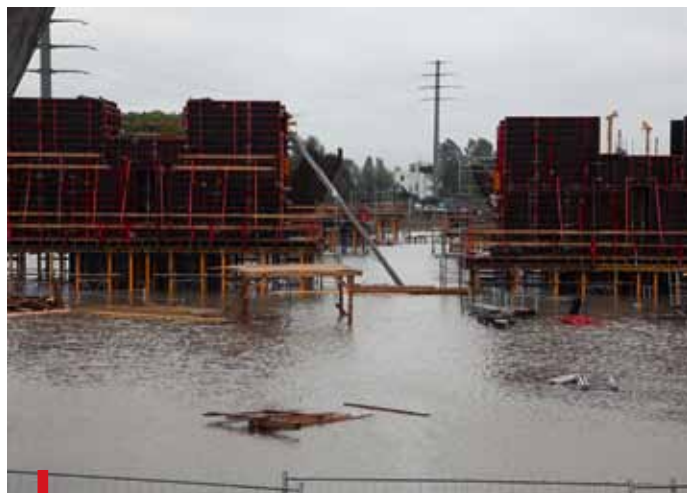
Zalane tereny budowy autostrady A1
