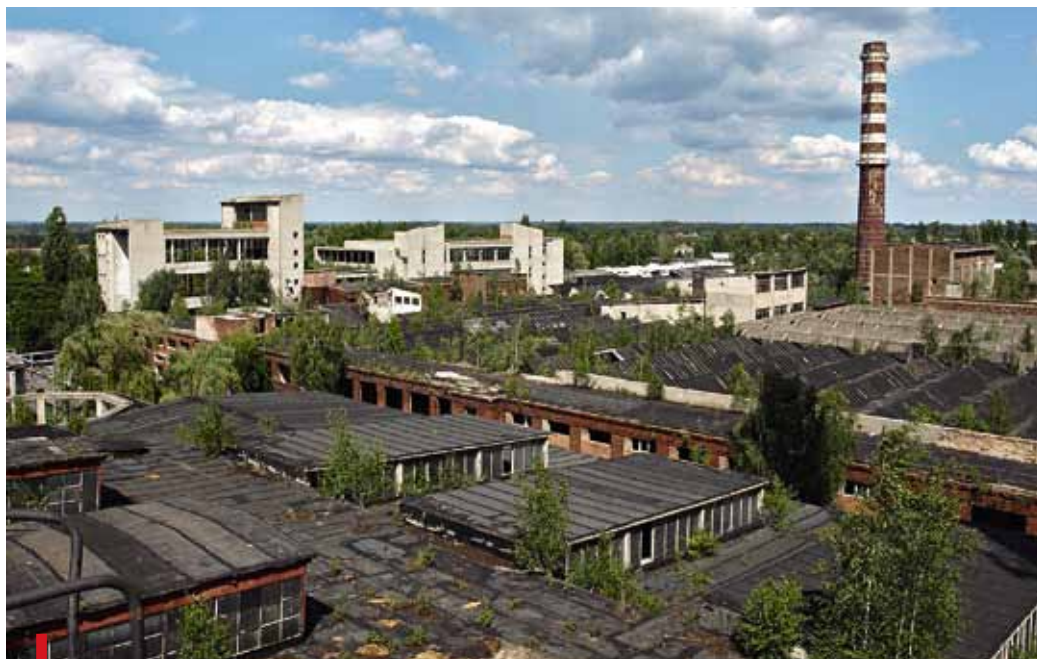
Ruiny Chodakowskich Zakładów Włókien Sztucznych Chemitex
