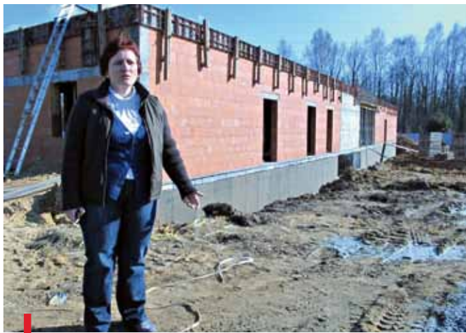
– Położenie domu hospicyjnego tuż przy alei Bielskiej i nieopodal lasu jest idealnym rozwiązaniem – mówi Wiesława Sieczka
