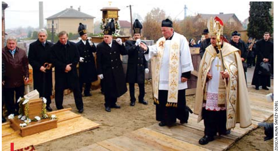
Gość ze Lwowa na placu budowy nowej ochronki
