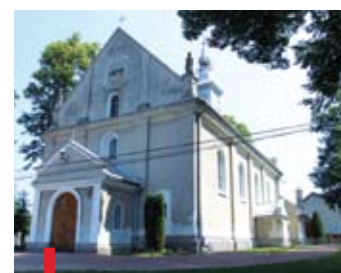
Kościół w Ślęzakach zostanie poddany remontowi
