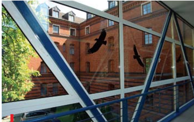
Wyższe Seminarium Duchowne Diecezji Gliwickiej mieści się w Opolu. Budynek dawnych koszar jest połączony z nowoczesnym kompleksem
