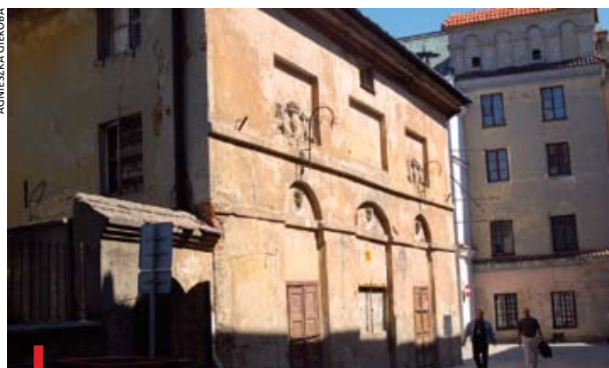
Prace remontowe w Teatrze Starym zostały przerwane z powodu braku pieniędzy
