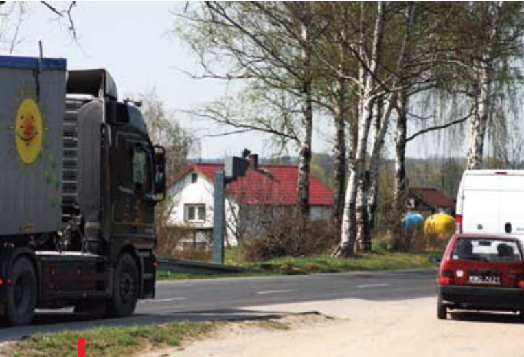
Obwodnica, która miała ominąć Olszynę, biegnie pomiędzy ciągiem budynków miasta. Wiadomo było, do czego to doprowadzi
