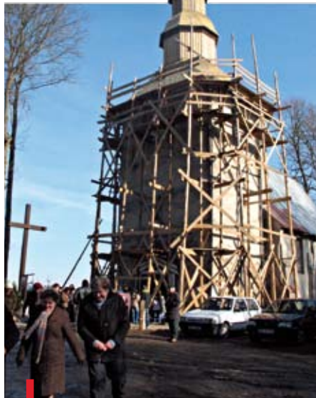
W tym roku czas na remont dachu
