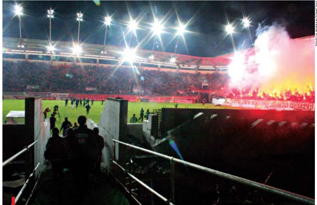
Dialog Arena, jeden z najnowocześniejszych stadionów w Polsce, ma zostać ukończony wiosną przyszłego roku. Inwestycja będzie kosztować ok. 100 mln złotych
