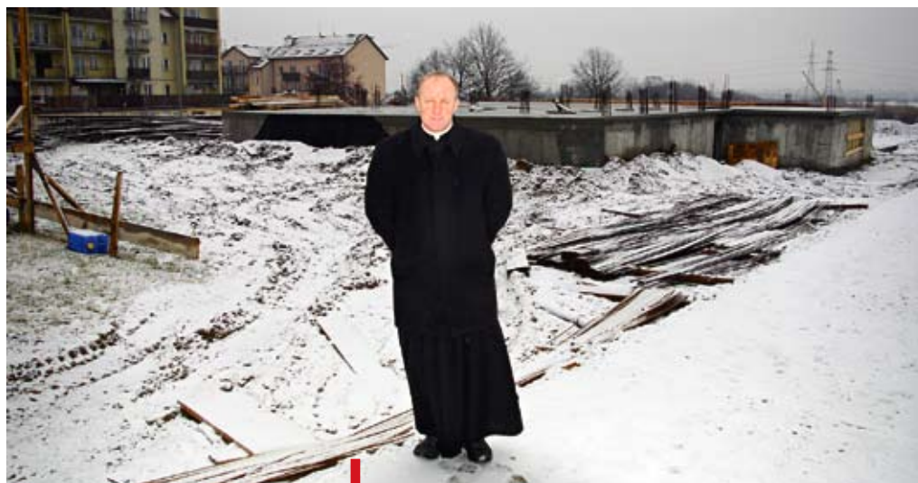
– Na razie mamy ukończony tzw. stan zerowy budowy świątyni – mówi ks. proboszcz Jan Jarco
