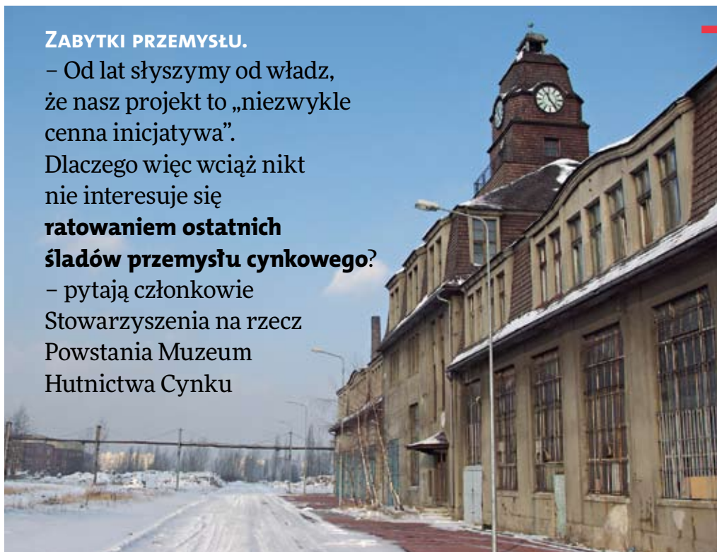
Budynek dyrekcji huty czeka na nową funkcję PONIŻEJ: Wieża ciśnień stoi na terenie dawnej Huty „Uthemann”
