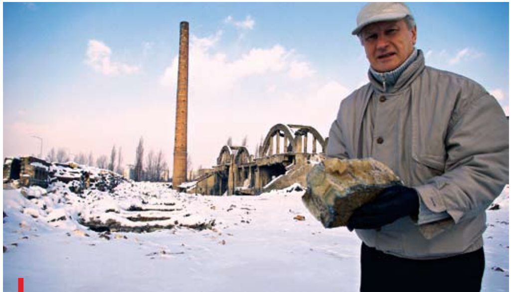
Gerard Sacherski pokazuje gruzu, jakie pozostały po hali pieców destylacyjnych PONIŻEJ: – Jeśli zabraknie ochrony nad budynkiem walcowni, szybko pojawią się tu złodzieje – stwierdza Andrzej Karasiewicz zamykający drzwi hali
