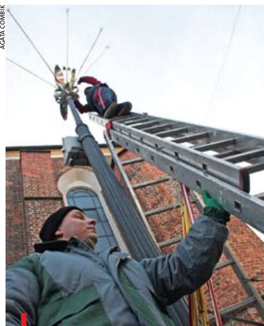
Zenek (u góry) i Robert z wołowskiego Zakładu Karnego montują przy kościele pierwsze świąteczne dekoracje
