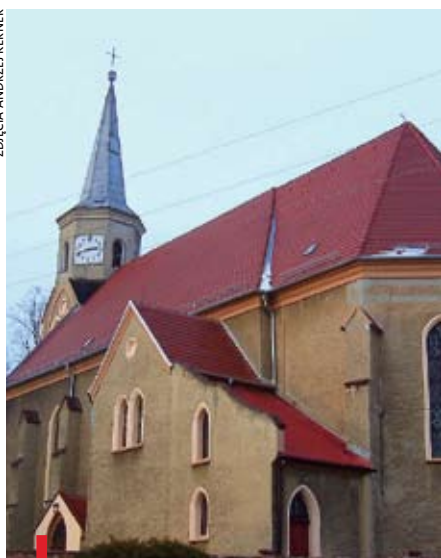
Kościół parafialny z nowym dachem
