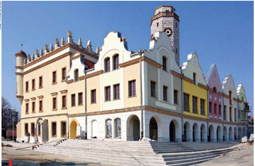
Głubczycki ratusz w końcowej fazie budowy
