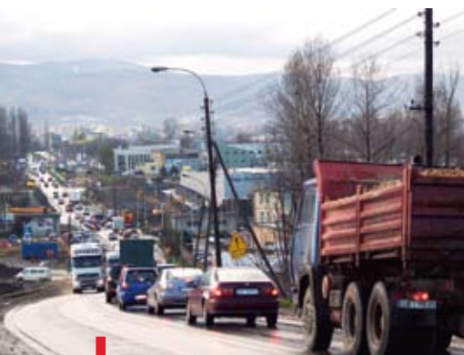
Ruszyły już prace w rejonie ulic Wyzwolenia i Niepodległości. Tu powstanie wiadukt – i znikną korki
