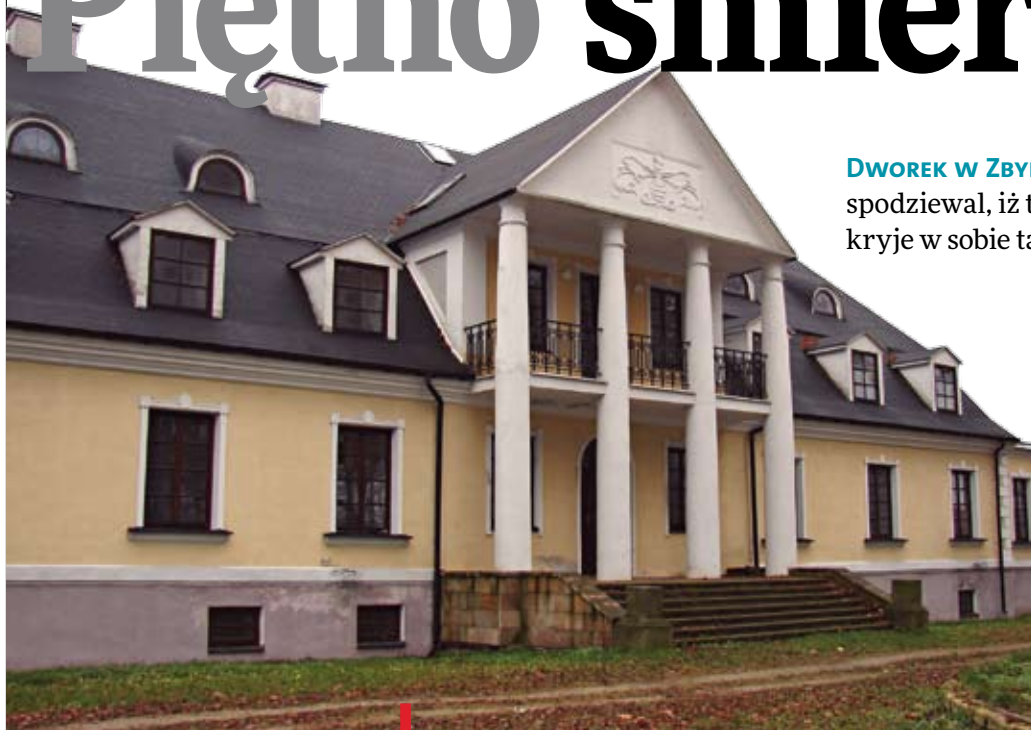
Dworek w Zbydniowie w trakcie renowacji
