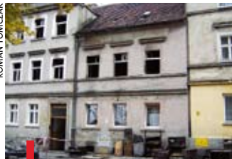
Stan kamienicy, gdzie spłonęły mieszkania, bada specjalna komisja
