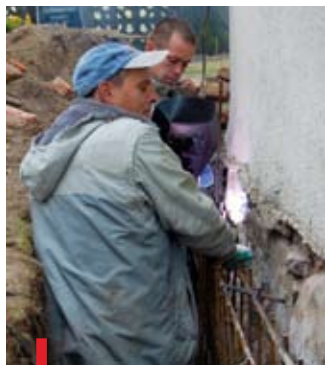
Prace zabezpieczające realizowane są w ramach Projektu napraw i zabezpieczeń KGHM – Polska Miedź SA Oddział Zakładu Górniczego „Polkowice–Sieroszowice”
