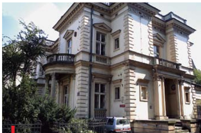
W sierpniu rozpoczął się remont zrujnowanego dachu zabytkowego Pałacyku Czapskich, gdzie znajdują się cenne zbiory numizmatyczne
