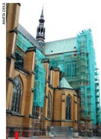
Zachodni transept i część nawy przykryte rusztowaniami
