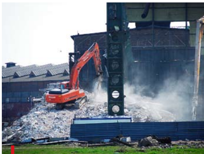
Stocznia dzisiaj. Trwa rozbiórka budynków postoczniowych
