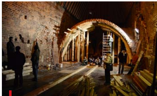
Prace przy gotyckim sklepieniu prezbiterium.
