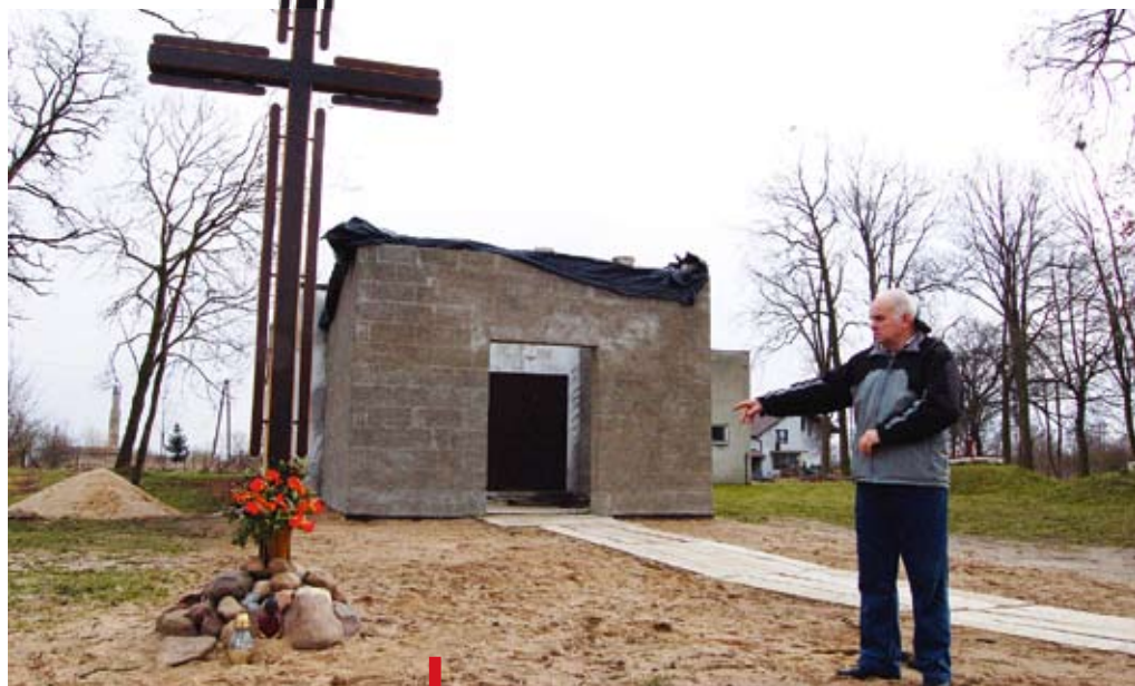
Jan Kardaś opowiada o rozbudowie kaplicy w Pęcławiu zaadaptowanej ze starej hydroforni
