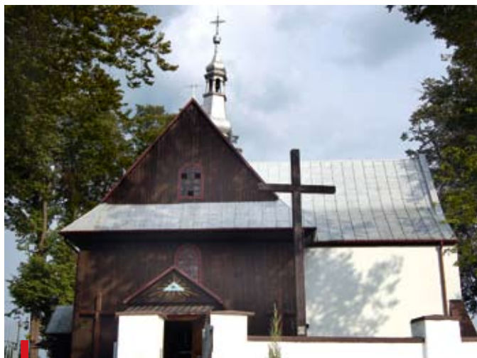
Kościół jest budowlą częściowo drewnianą o konstrukcji zrębowej. PONIŻEJ Odnowiona figura św. Jana Nepomucena
