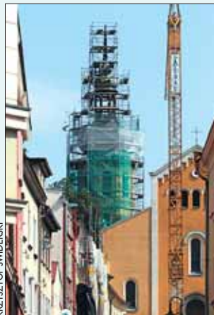
Remont wieży kościoła „na Górcę” potrwa do listopada
