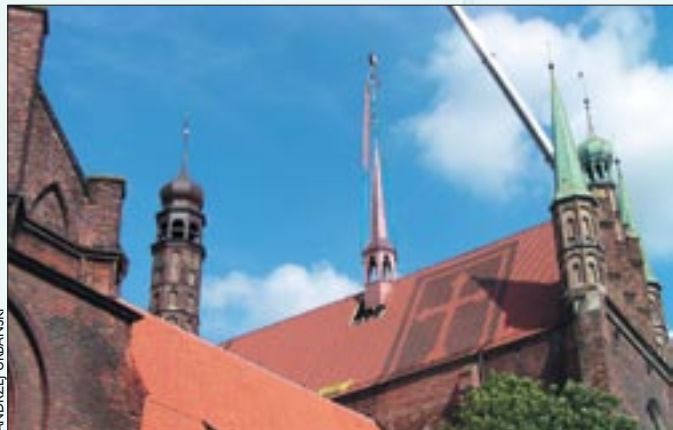
Moment osadzania wieży na dachu kościoła
