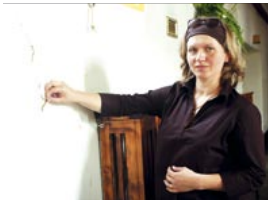
Z powodu szkód górniczych na ścianach kościoła pojawiły się rysy. Podczas remontu radą służy mieszkająca w parafii architekt Bożena Zając
