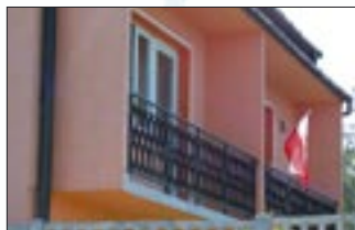
Balkon prywatnego domu w Wierzbicy
