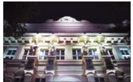
Fasada dyrekcji Ballestremów w Gliwicach
