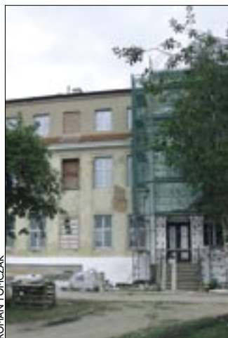
Remont ścinawskiego ośrodka ma zakończyć się w styczniu przyszłego roku
