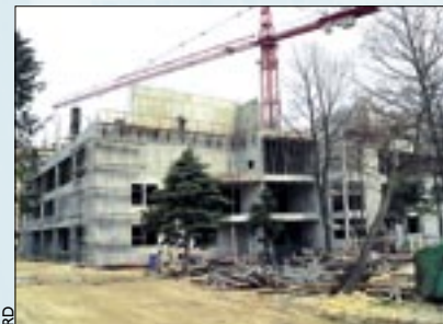
Tempo prac przy budowie daje nadzieję na szybkie powstanie pracowni hemodynamiki i oddziału onkologicznego
