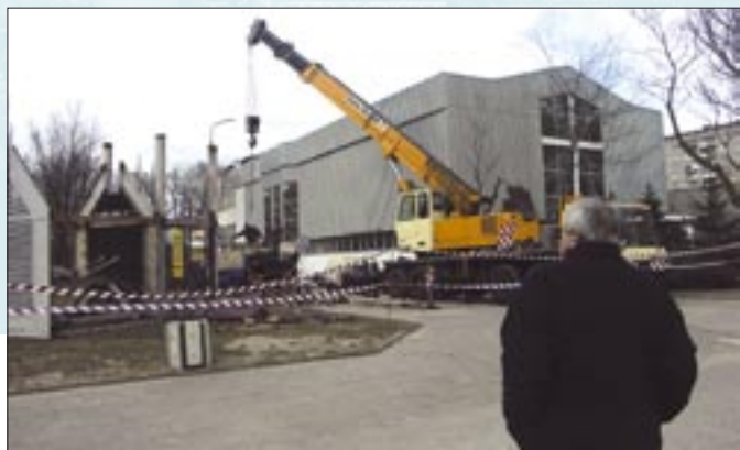
Ruszyła przebudowa i remont kościoła Chrystusa Odkupiciela
