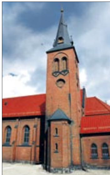
Niedawno zmieniono pokrycie dachu kościoła parafialnego i wieży
