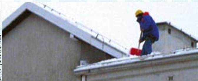
Specjalistyczna ekipa odśnieżała dachy bloków przy al. KEN w Warszawie
