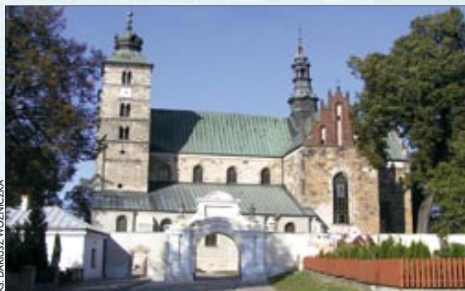
Kolegiata w Opatowie od kilku lat przygotowywała się do swojego jubileuszu m.in. poprzez liczne remonty
