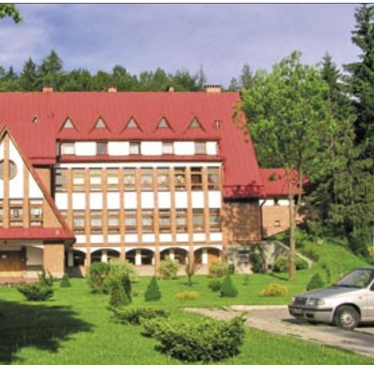
ARCHIWUM DOMU REKOLEKCYJNEGO W KORBIELOWIE
