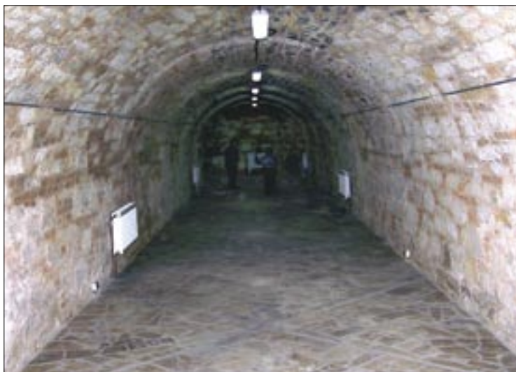
Podziemia łączące plebanię z wikarówką, zagospodarowane przez obecnego ks. proboszcza stają się hitem turystycznym Szewny. Mają 35 metrów długości, 3,5 m szerokości, 2,5 m wysokości. Ks. proboszcz chce tu utworzyć kawiarenkę dla młodzieży.
