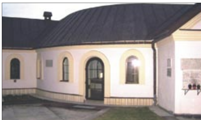
W tym pomieszczeniu będzie się mieścić m.in. punkt sprzedaży „Gościa Niedzielnego”
