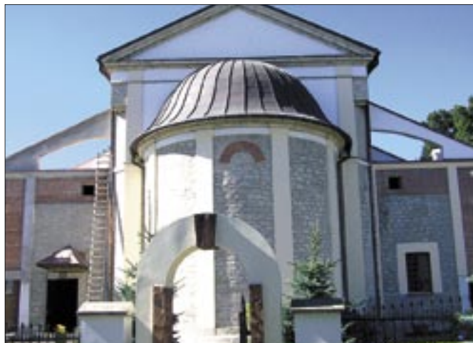
Do świątyni dobudowywane zostały dwie nawy boczne
